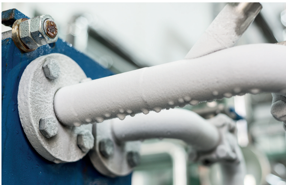
Fig. 1: Bevroren condens op een leiding.
