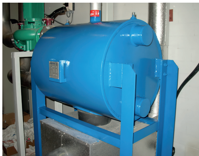
Fig. 2: Condensor parallel aan luchtgekoelde condensor.
