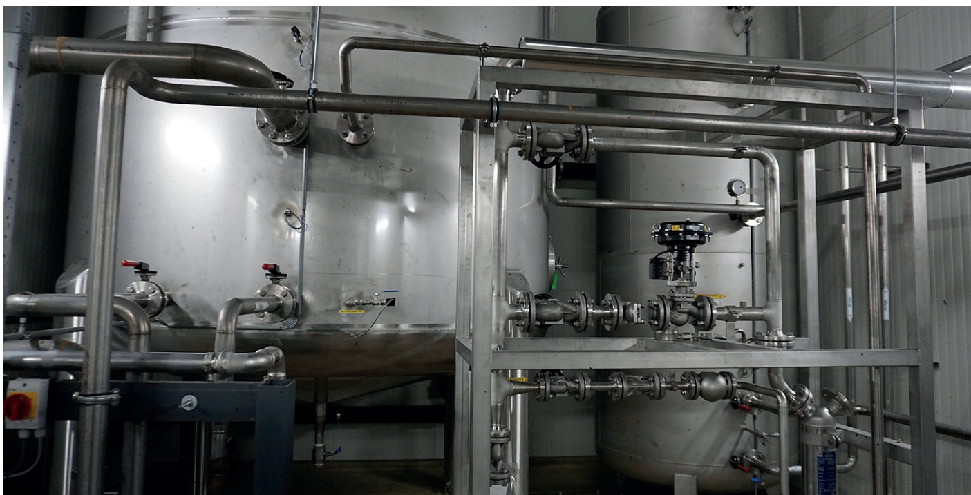
Fig. 3: Warmteterugwinsysteem met buffertanks.
