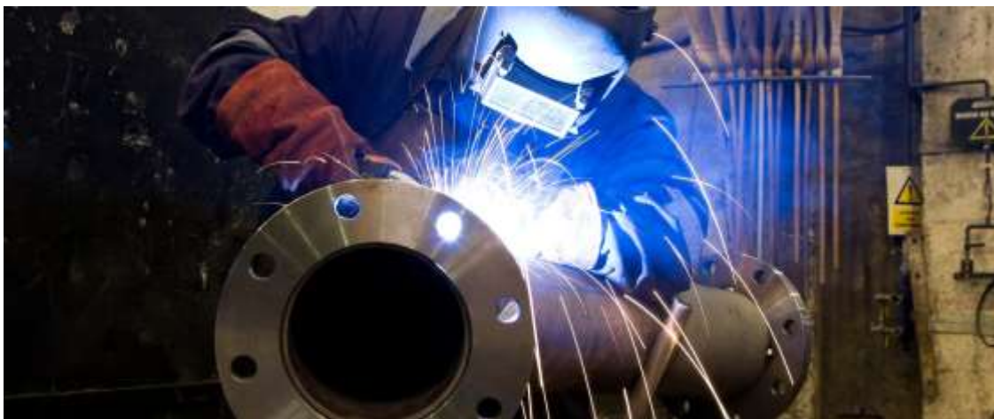
Fig. 2 Het lassen van stalen leidingen
