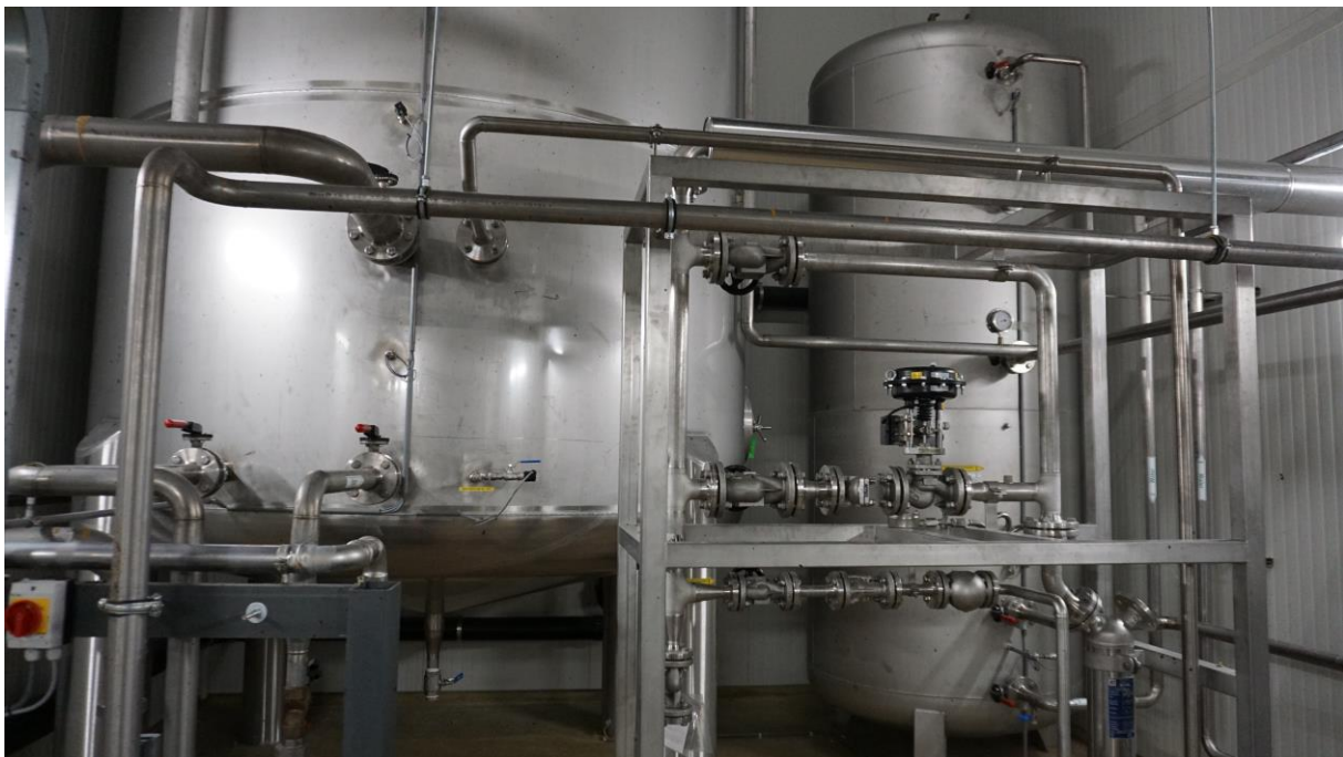
Fig 3: Warmteterugwinsysteem met buffertanks
