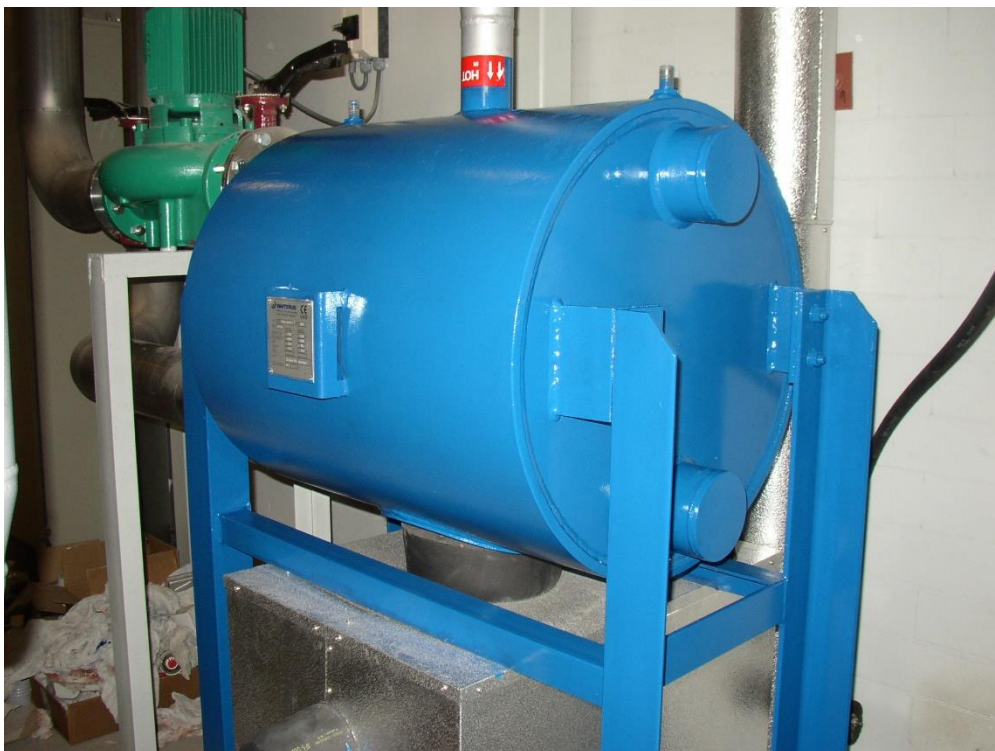
Fig 2: Condensor parallel aan luchtgekoelde condensor
