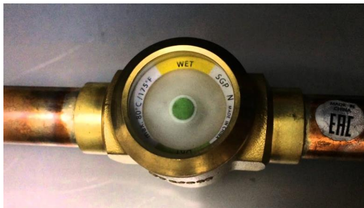
Figuur 3: Bepalen van de vulling met een kijkglas
