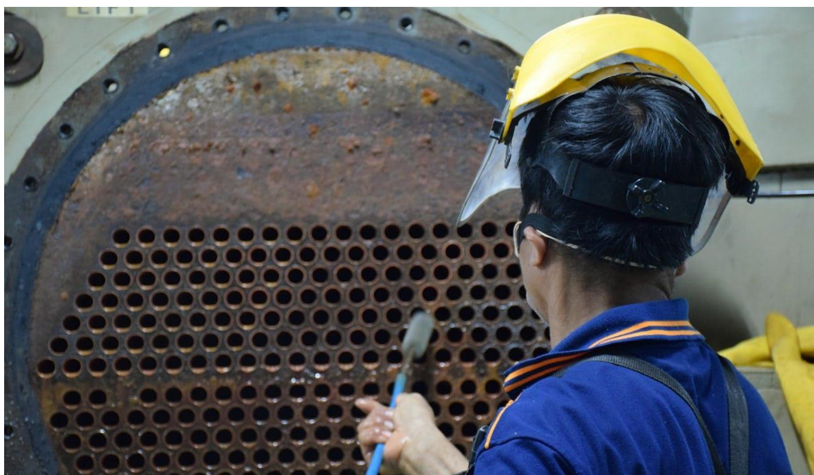
Afb 1. Reiniging van een shell & tube-wisselaar.
