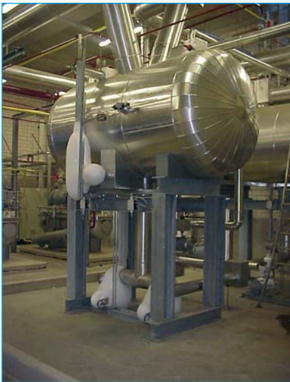
Foto 1: Typisch voorbeeld van een afscheider met pompen
