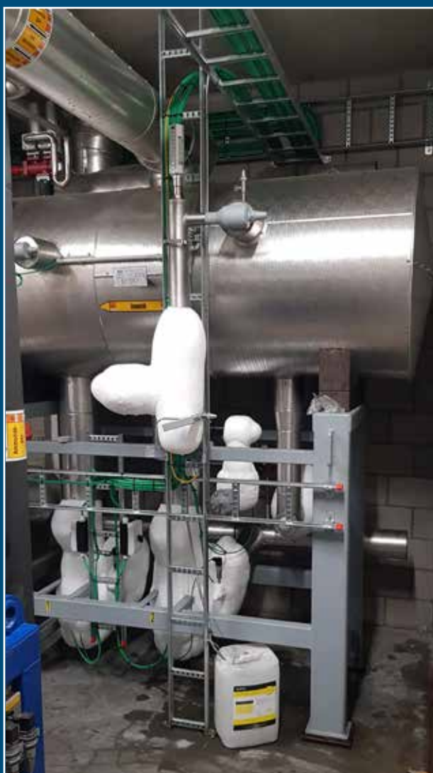
\text{NH}_3 afscheider met pompen
